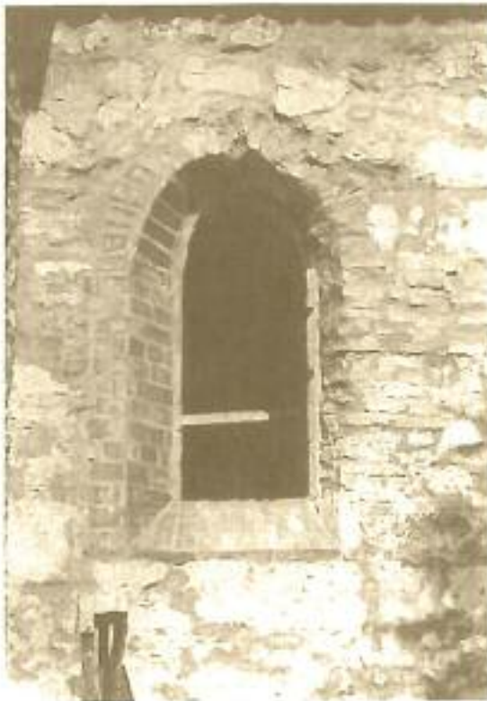
7. A szentély eredeti ablaka helyreállítva
